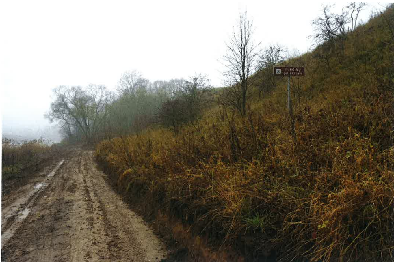
Nr. 1. Piliakalnio teritorijoje įrenginėjamas 3 m. pločio pravažiavimas. Technikos pagalba nuo upės pusės ardomas piliakalnio šlaitas
