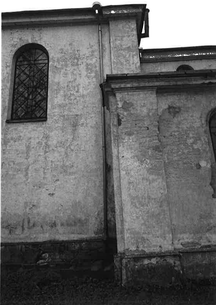
Nr. 4. Pastato fragmentas iš pietinės pusės. Reikalinga atkasti žemes nuo pamatų
