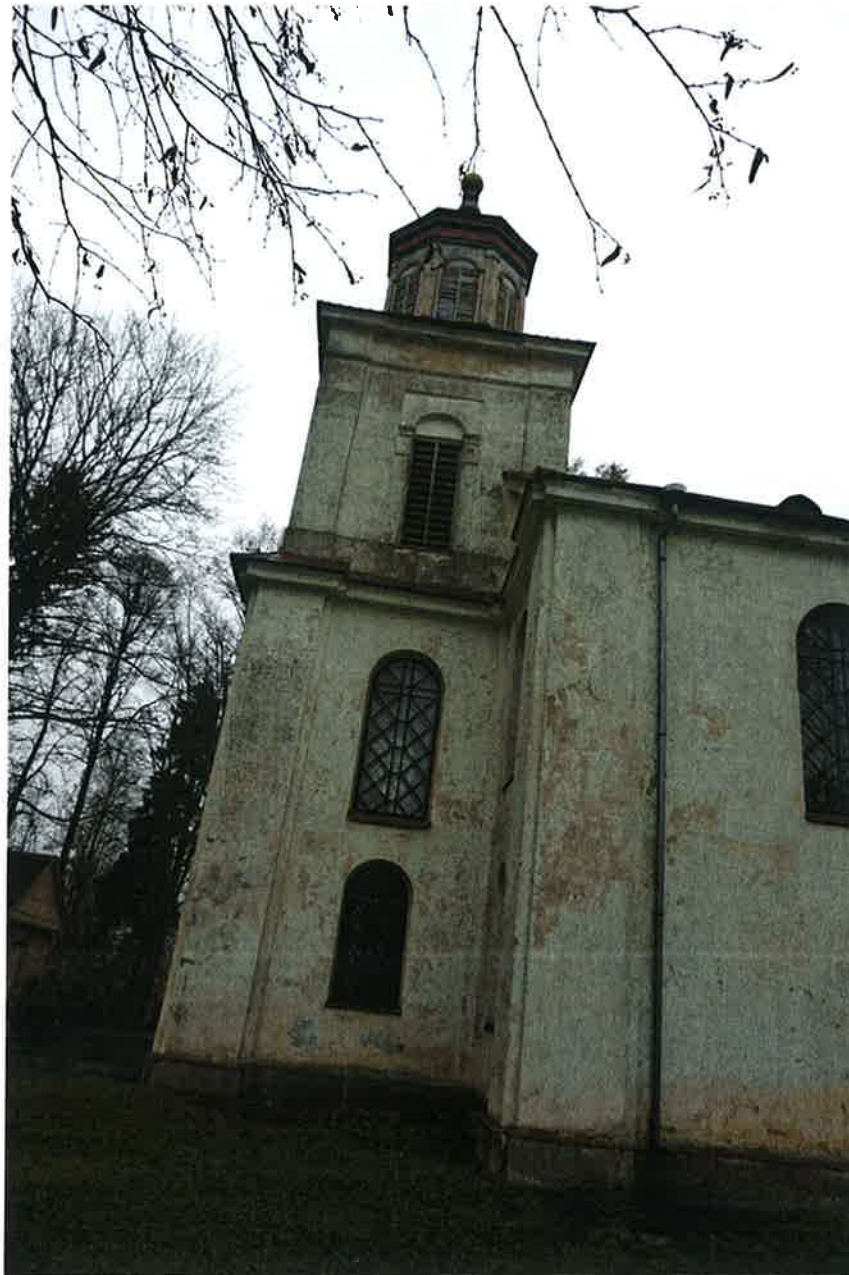
Nr. 1. Bažnyčios fasadas iš pietinės pusės.
