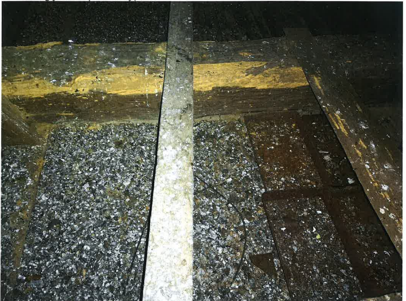
Nr.12. Stogas vietomis kiauras, minimaliomis priemonėmis skardinėmis blėtomis surenkamas vanduo.
