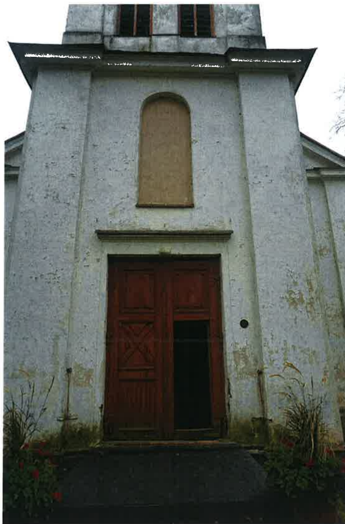
Nr. 7. Pagrindinis įėjimas į bažnyčią, kurio laipteliai 2019 m. buvo dalinai pakeisti, paliktos tik metalinės pakopos.
