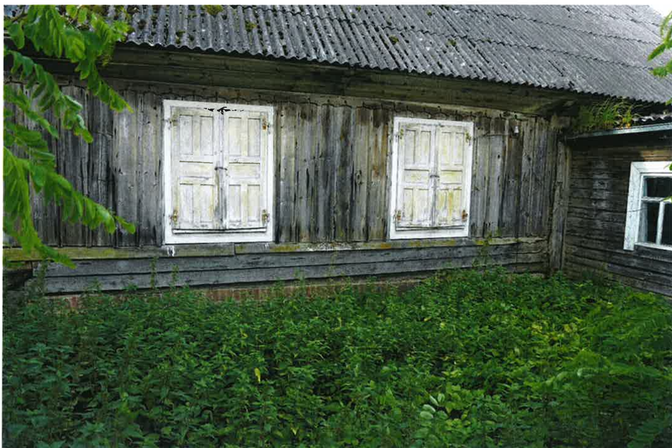
7. Pastatas iš ŠR pusės. Autentiškos medinės langinės
